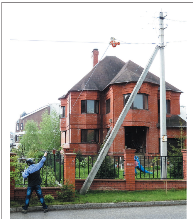
Рис.12. Протяжка навивной машинки с бухтой кабеля за фаловую веревку в пролете вдоль улицы
